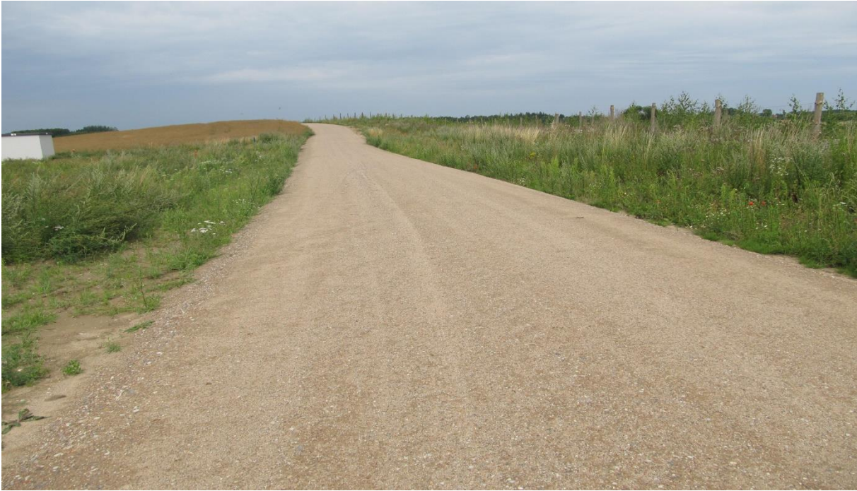
Zdjęcie 7. Droga gruntowa granicząca od wschodu z terenem opracowania
