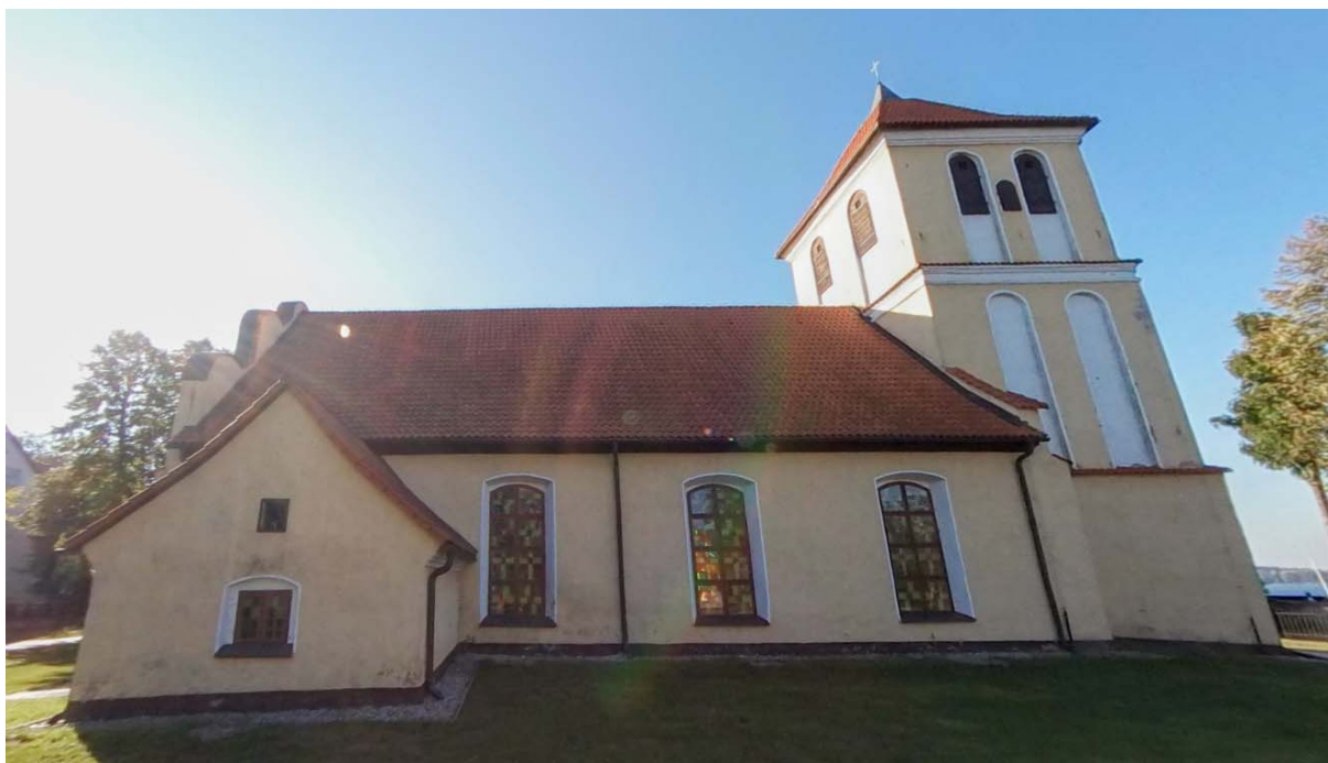
Fot. 5 Elewacja północna
